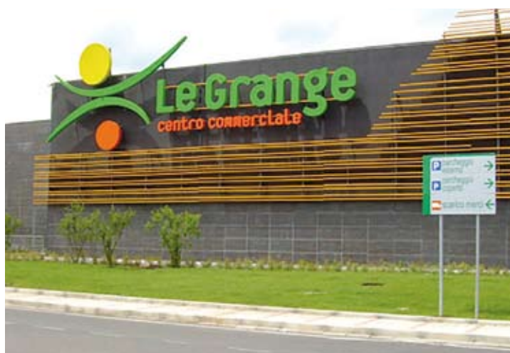
Il centro commerciale Le Grange a Piedimonte San Germano (Fr)
